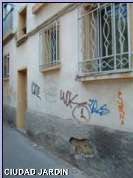
HUMEDADES EN LA BASE DEL MURO
